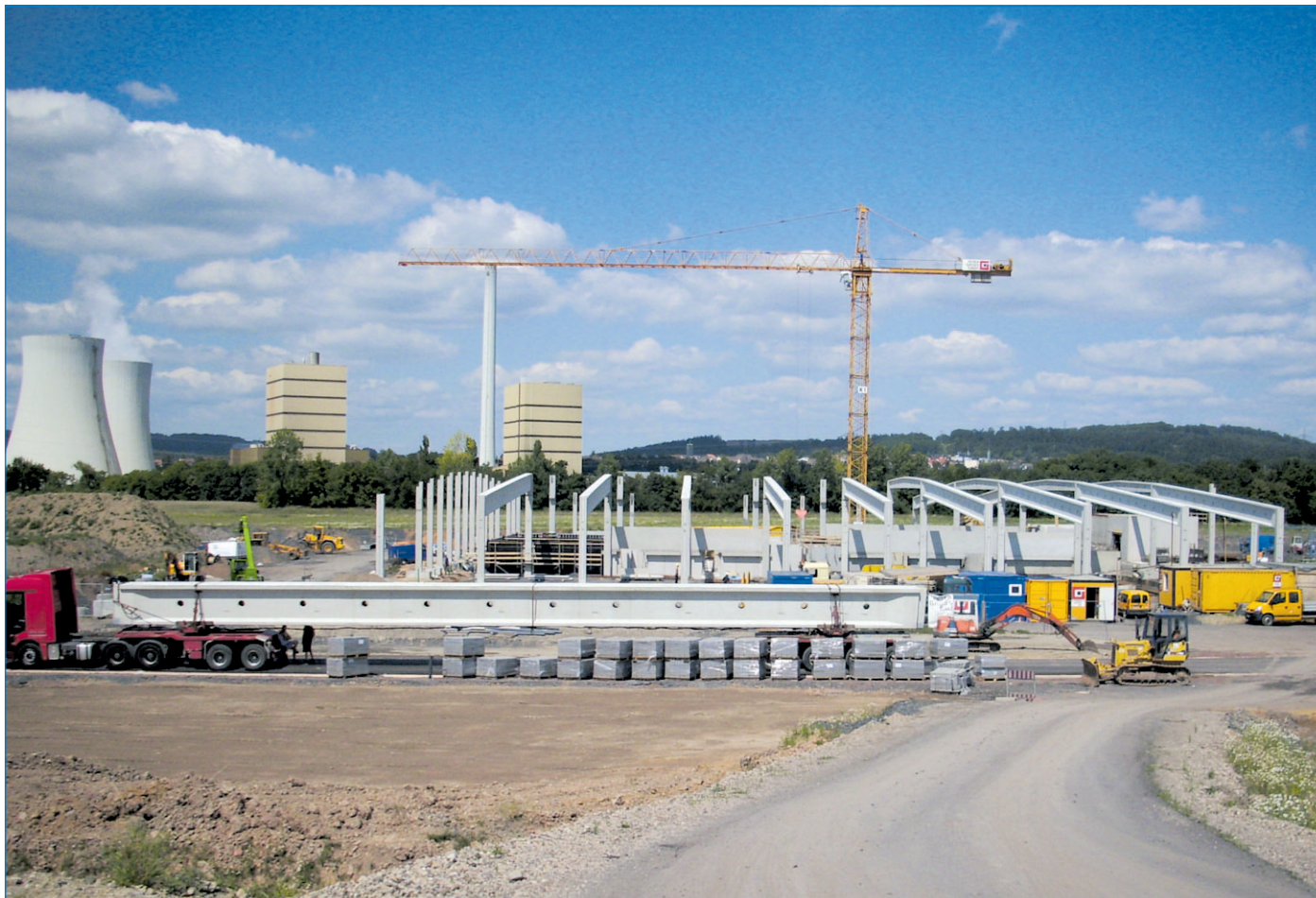
Vier Monate nach dem Spatenstich kann nun in Völklingen-Fürstenhausen Richtfest für die Meeresfischzuchtanlage und die Forschungshalle gefeiert werden. Foto: swv
